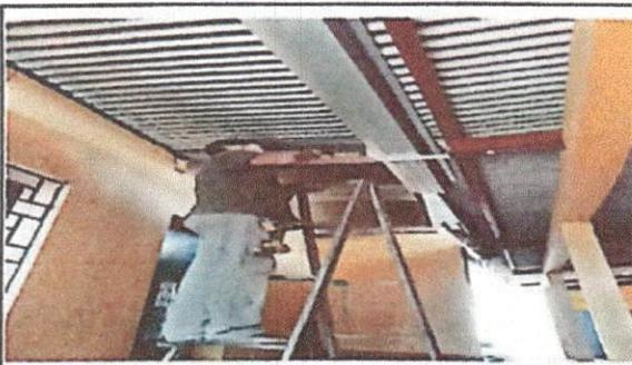
Foto 5: Sustitución de canal de metal debido que esta en mal estado y hay partes que no tiene y el agua pluvial cae en los corredores.
