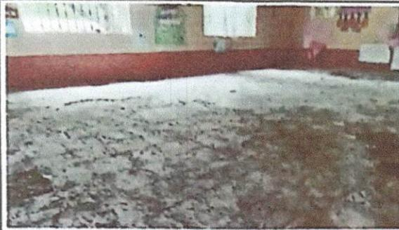
Foto 1: Sustitución de piso cerámico debido a que se encuentra en mal estado.
